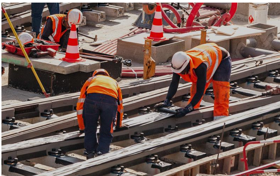
Ilustração 7- Equipe de manutenção atuando nos trilhos
